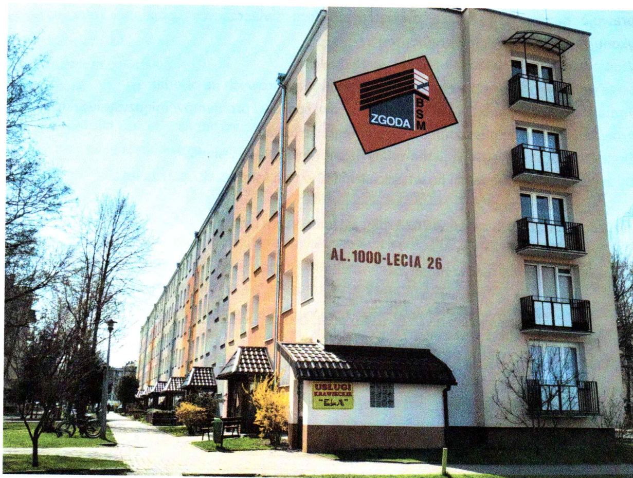
Foto: elewacja północno-wschodnia
