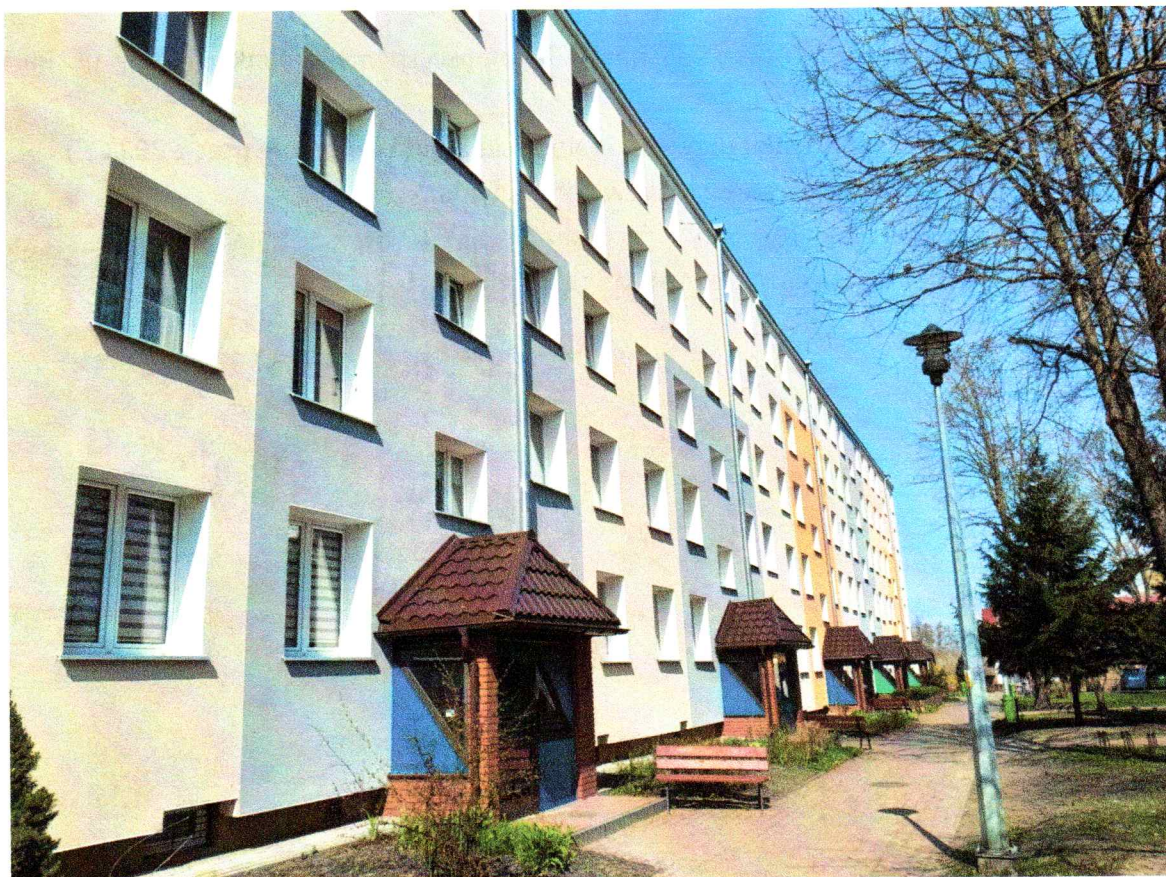
Foto: elewacja wschodnia
